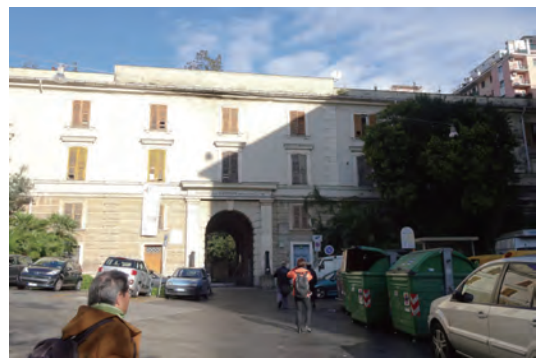
写真4 道路からの外観・アクセスゲート
