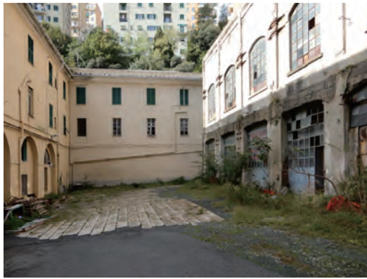
写真 13 保存建物（左）と解体建物（右） 左が中庭のある（地区の家が入っている）保存建物。右が解体予定の建物。正面に敷設された舗装は歴史的価値が認められるため保存指定。
