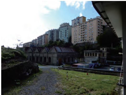
写真 14 敷地内から西側周辺をみる 手前に保存する軍用工場。奥に高密度な集合住宅が迫る。
