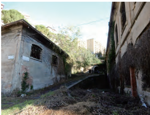
写真12 取り壊し予定の建物と敷地東側をみる
