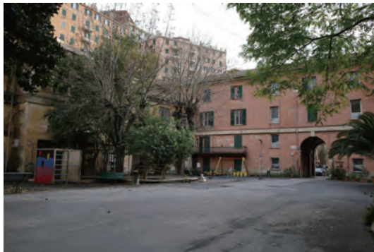
写真5 広場の全景，背後の建物の一部が地区の家
