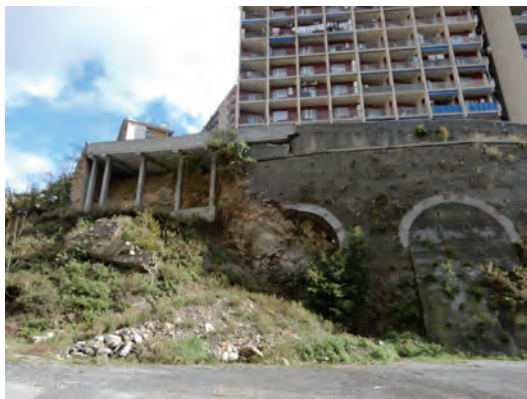
写真 15 敷地内から東側周辺をみる 敷地とのレベル差が大きく、擁壁が一部くずれている状態。
