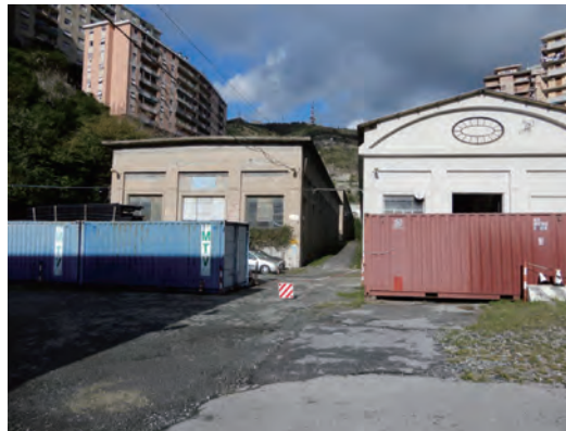
写真10 敷地北側の現行軍用施設
